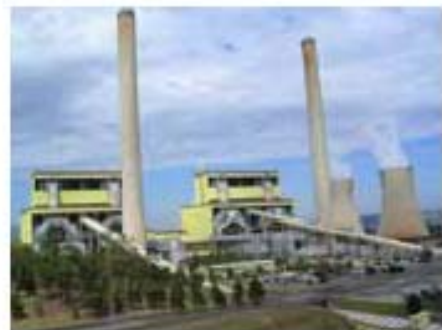
Loy Yang Power Station
